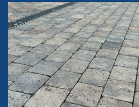
Pflasterarbeiten und Randeinfassungen
